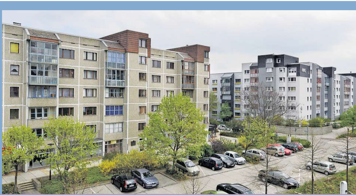
In den 80er Jahren wurde in Halle (Brunos Warte) versucht mit Platten abwechslungsreichere Wohn-Architektur anzubieten. Entworfen wurde das Ensemble vom Architekten Wulf Brandstädter, der dafür den DDR-Architekturpreis erhielt. Links das Original im unsanierten Zustand, rechts der vor wenigen Monaten modernisierte Teil, bei dem die historische Struktur bewahrt wurde. FOTO: THOMAS MEINICKE
